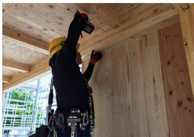
木質構造用ねじの施工例
