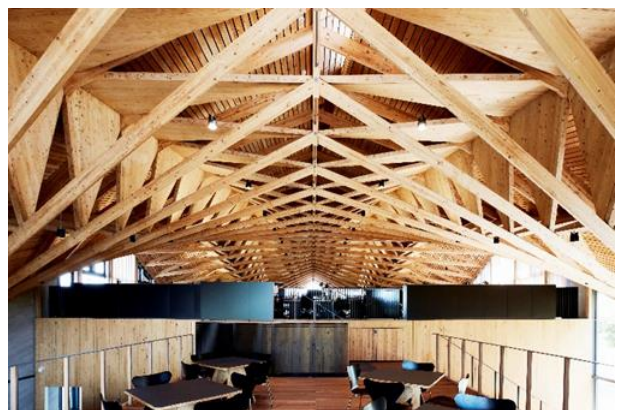
木質構造用ねじを用いた中大規模木造建築物の例（出典：シネジック株式会社）
